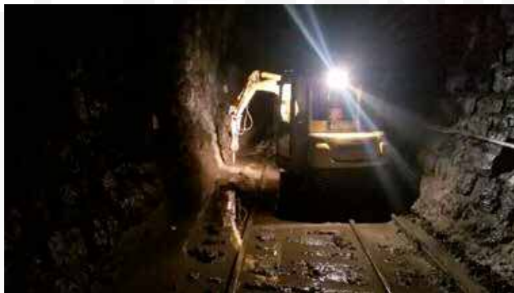
Slika 5. Pripremljeni iskopi podloge, nova drenažna središnja linija i novi pragovi i tračnice za postavljanje
