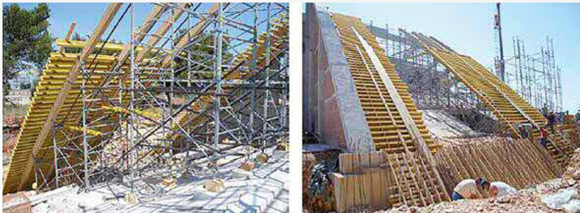
Slika 9. Postavljanje oplata i skele
